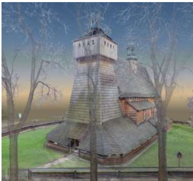
Рис. 3 Церква Успіння Пресвятої Богородиці в Хачові. Польща. Зображення насправді є хмарою точок, отриманою в результаті лазерного сканування пам'ятки (сучасний метод цифрової документації, що використовує лазерні сканери для створення дуже точних 3D-моделей споруди). Джерело: сайт «Digital UNESCO», сторінка, присвячена церкві в Хачові. https://digitalunesco.pl/portfolio-item/haczow-en/
