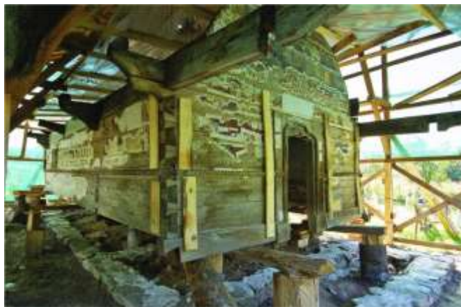
Рис. 14 Дерев'яної церкви в селі Урші, повіту Валча, під час реставраційних робіт. Дах церкви було піднято, а зовнішній розпис – укріплено, щоб реставраційні роботи над конструкцією не зашкодили розписаним поверхням. Джерело: Журнал «IGLOO», № 203 за 2021 рік. Доступно за адресою: https://www.igloo.ro/biserica-de-lemn-din-satul-ursi-restaurata-de-fundatia-pro-patrimonio-printre-castigatorii-premiilor-europene-pentru-patrimoniul/
