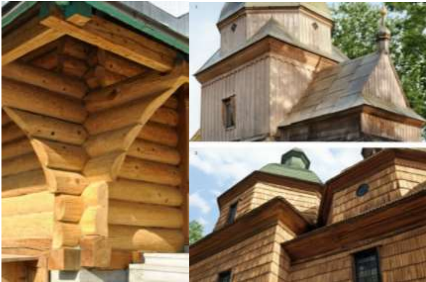
Рис. 6. Піддашшя, яке опирається на випуски вінців зрубу, гімс та ґонт на стінах храму
