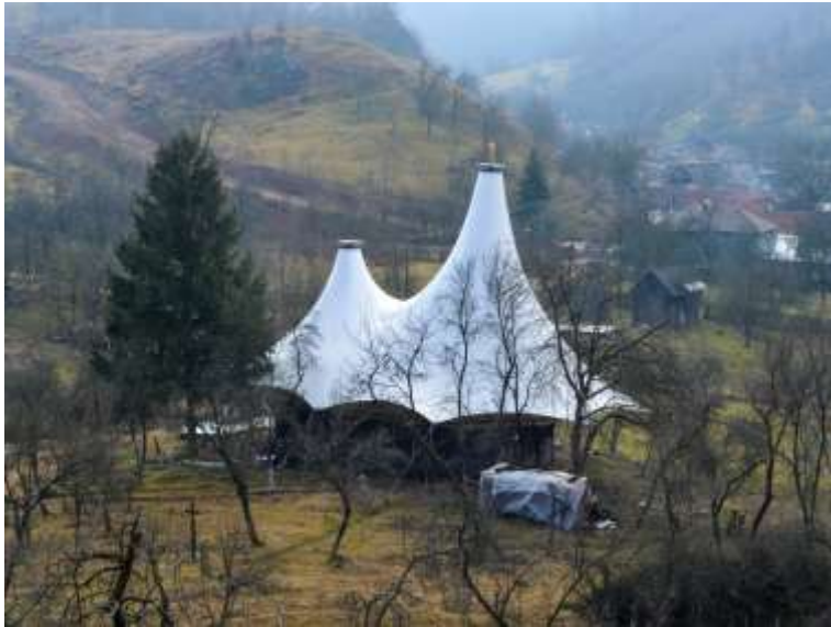
Рис. 13 Робота команди «Biserici Înlemnitate» у Кривіні-де-Сус. Захисна конструкція дерев'яної церкви, повіту Тіміш. Джерело: Журнал «Zreepelin» № 141 за 2016 рік, https://e-zeppelin.ro/despre-adapost-regasire-si-o-acoperire-provizorie-a-bisericii-de-lemn-din-crivina-de-sus/
