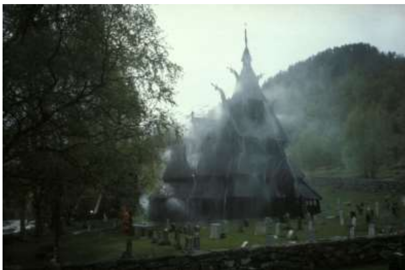
Рис. 21 Дерев'яна церква в Боргунді, Согн, Норвегія, під час випробування системи пожежогасіння зі спринклерами у 1982 році. Джерело: (Larsen/Marstein, 2016, с. 76)
