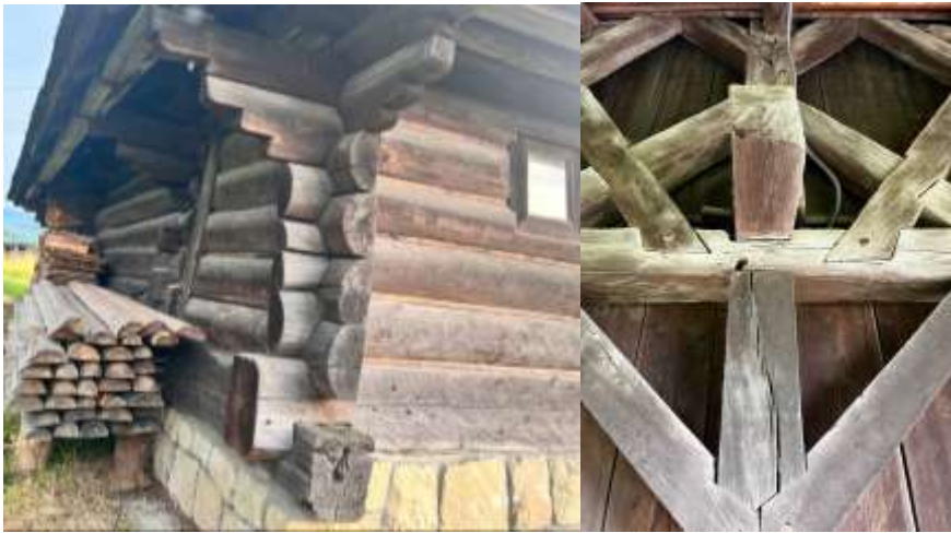
Рис. 5. Зрубна та каркасна конструктивна схема у сакральному дерев'яному будівництві
